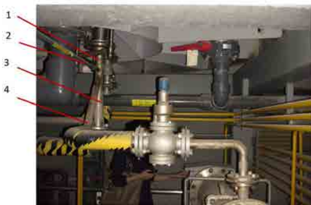
Рис.3. Устройство ввода реагента.
