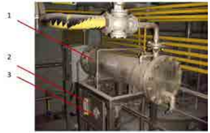
Рис.5. 1-сатуратор; 2-ротаметр; 3-манометр.
