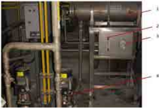
Рис.4. 1-сатуратор; 2-ротаметр; 3-манометр; 4-циркуляционный насос.
